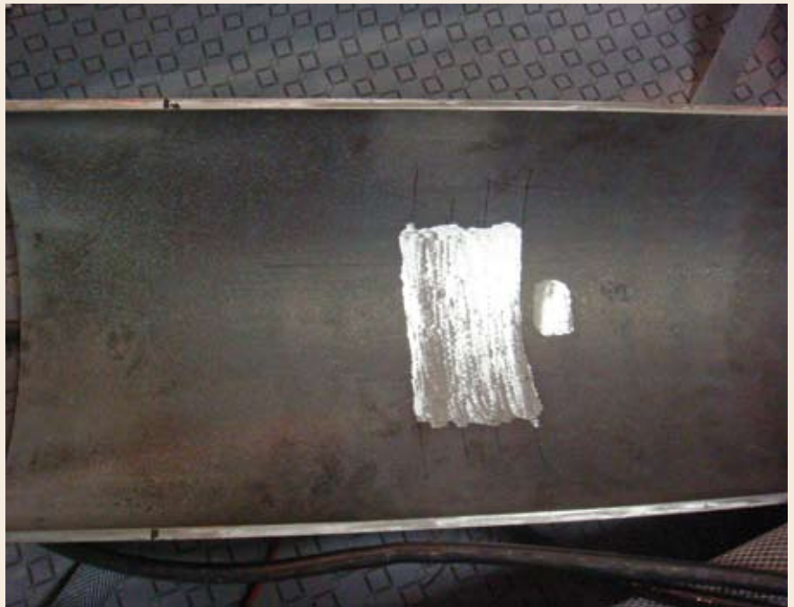
Рис. 4. Внутренний вид модели трубы с искусственно нанесенными дефектами, имитирующими повреждения от коррозии
