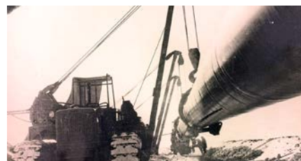
Фото 5. На строительстве магистрали Бухара – Урал
