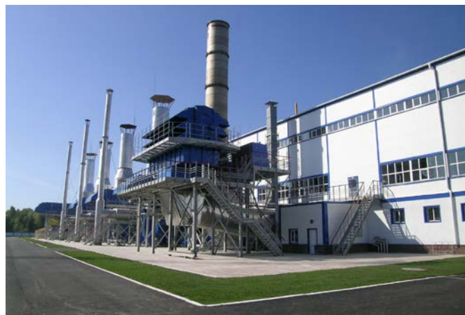
Фото 8. Компрессорная станция КС-18А «Москово»
