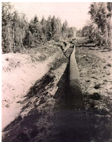
Фото 2. Газопровод Туймазы – Уфа – Черниковск перед укладкой в траншею, 1953 г.
