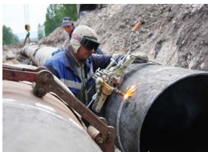
Фото 7. Задача газотранспортников – повышение надежности газопроводов
