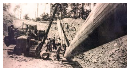
Фото 6. Строительство газопровода Челябинск – Петровск
