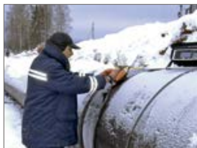
Рис. 5. Контроль эксплуатационного разнотолщинного сварного соединения DN 1220
