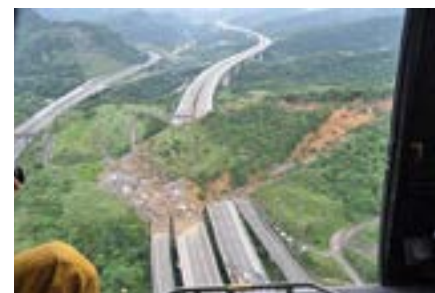
Рис. 3. Оползень, перекрывший федеральный автобан (Тайвань, 2010)
