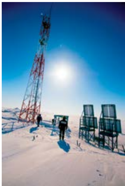
Рис. 2. Комплекс телемеханики «Гиперфлоу-ТМ» с питанием от ВИЭ в условиях Крайнего Севера
