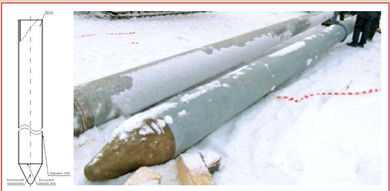
Рис. 3. Схема бурозабивной сваи
