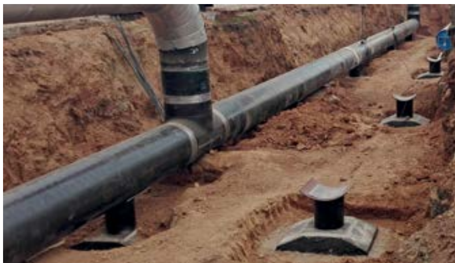
Рис. 3. Капитальный ремонт технологических трубопроводов площадки газоперекачивающего агрегата
