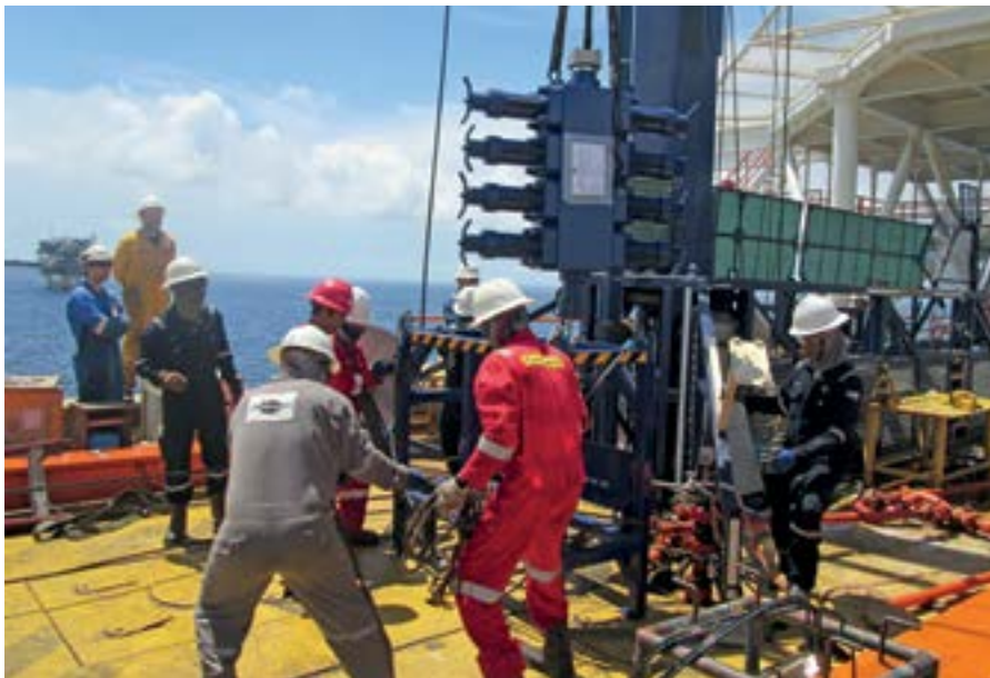
Рис. 6. Монтаж УЭЦН Colibri ESP на грузонесущем кабеле на платформе BODP-C компании Petronas (Малайзия), месторождение Bokok
