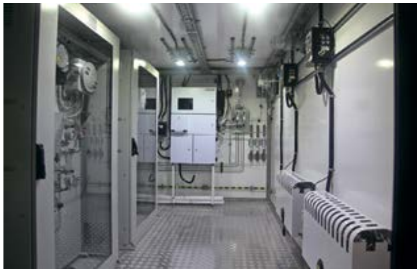
Рис. 2. Хроматограф «Хромос ПГХ-1000.1» (исполнение 2) в блок-боксе производства ООО «ХРОМОС Инжиниринг»
