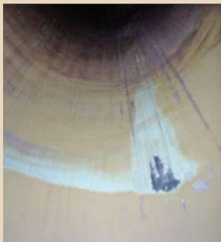
Рис. 2. Отсутствие следов коррозии в результате истирания покрытия ТК 236 каротажным кабелем (нефтедобывающая компания ВР)
