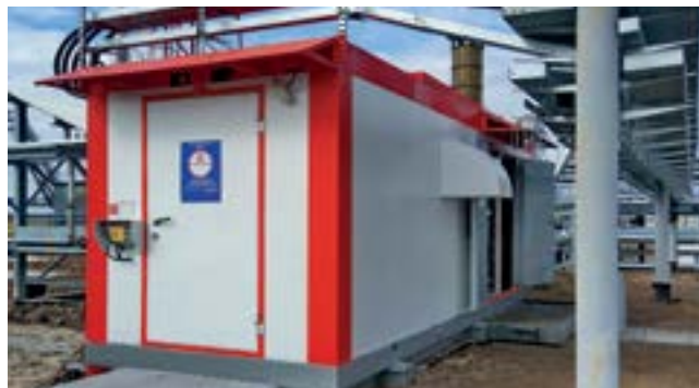
Фото 2. Модернизированная пусковая компрессорная установка для Восточно-Перевальной ГТЭС
