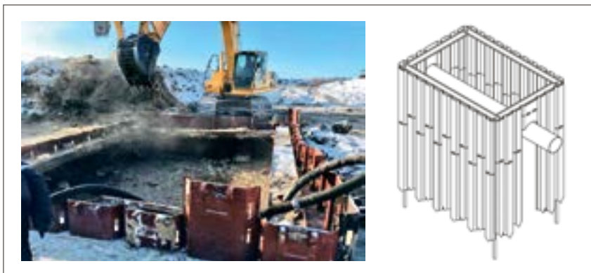
Сборно-разборное шпунтовое ограждение «Барьер-1 М»
