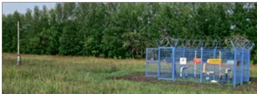
Рис. 3. Внешний вид объекта испытаний
