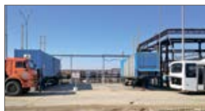
Рис. 2. ПАГЗ на производственной площадке месторождения Fig. 2. Mobile gas refueling truck at a field production site
