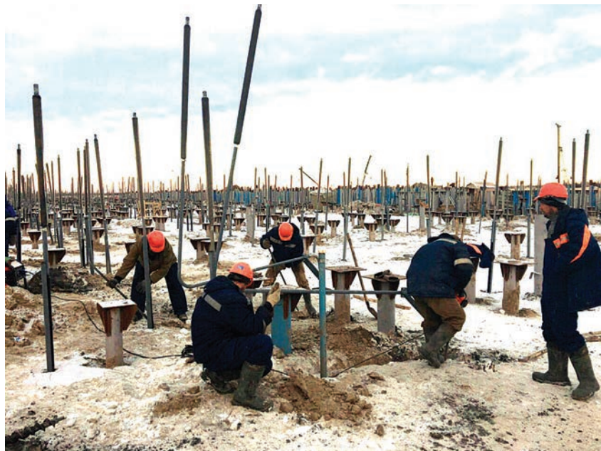
Рис. 7. Площадка с многочисленными термостабилизаторами для строительства обвязки на УКПГ ЗС Заполярного месторождения, октябрь 2016 г.
