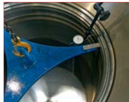
Рис. 6. Процесс нанесения, отверждения и контроля покрытия на «РМА РУС»
