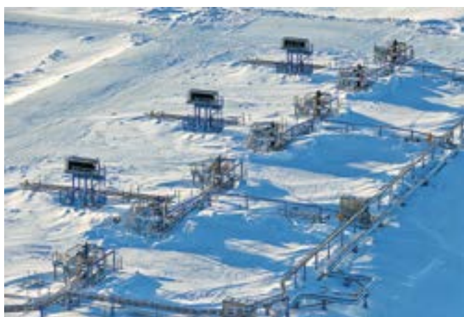
Рис. 1. Площадки кустов газовых скважин с системами температурной стабилизации грунтов «ВЕТ». Бованенковское НГКМ
