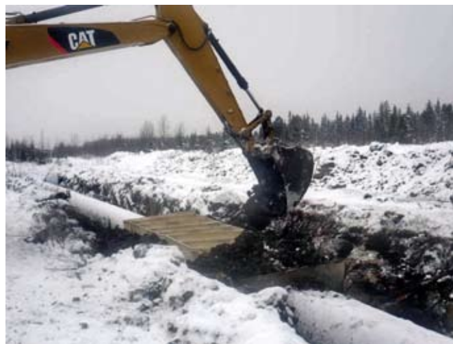
Рис. 7. Засыпка группы ПКУ экскаватором
