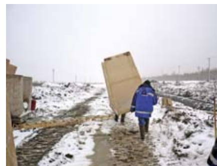
Рис. 5. Перенос ПКУ вручную
