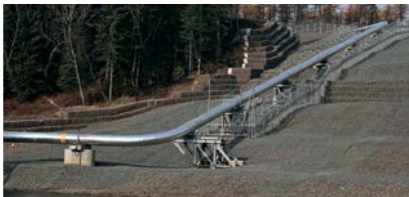
Рис. 4. Спланированный переход трубы через крупный водоток в средней части трассы
