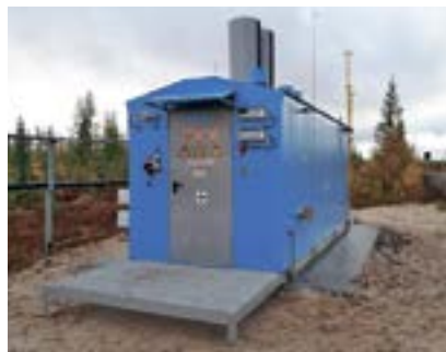
Рис. 2. Автономный источник питания АИП-400 на скв. № 814 Медвежьего НГКМ Fig. 2. Autonomous power supply AIP-400 on the well No. 814 of the Medvezhie oil and gas condensate field
