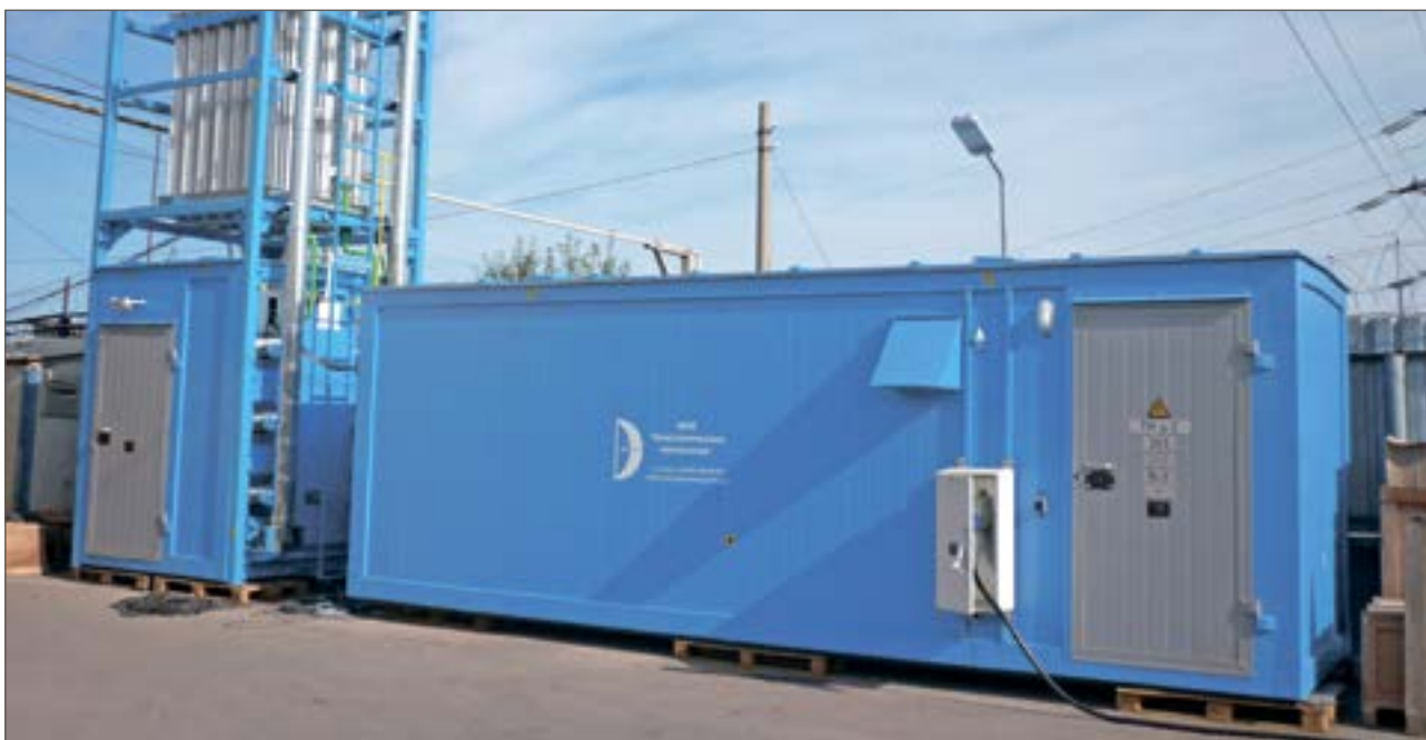
Рис. 4. Внешний вид источника автономного энергообеспечения на базе свободнопоршневого двигателя Стирлинга Fig. 4. Appearance of the source of autonomous power supply on the basis of the free-piston Stirling engine
