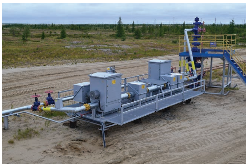
Рис. 3. Скважина, переведенная на эксплуатацию по концентрическим лифтовым колоннам без глушения
