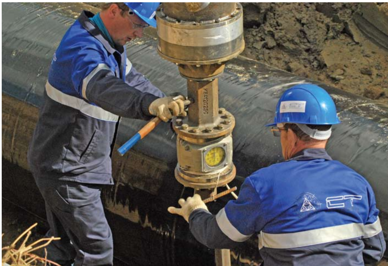
Рис. 2. Опытно-промышленные испытания на магистральном газопроводе «Ухта – Торжок 1»
