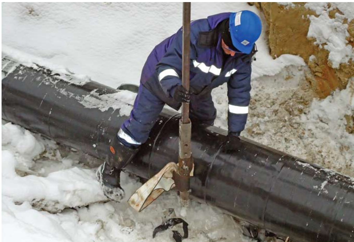
Рис. 4. Работы по закреплению продуктопровода ООО «Запсибтрансгаз»
