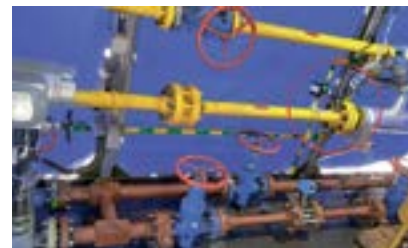
Рис. 2. Сужающее устройство с дифманометром
