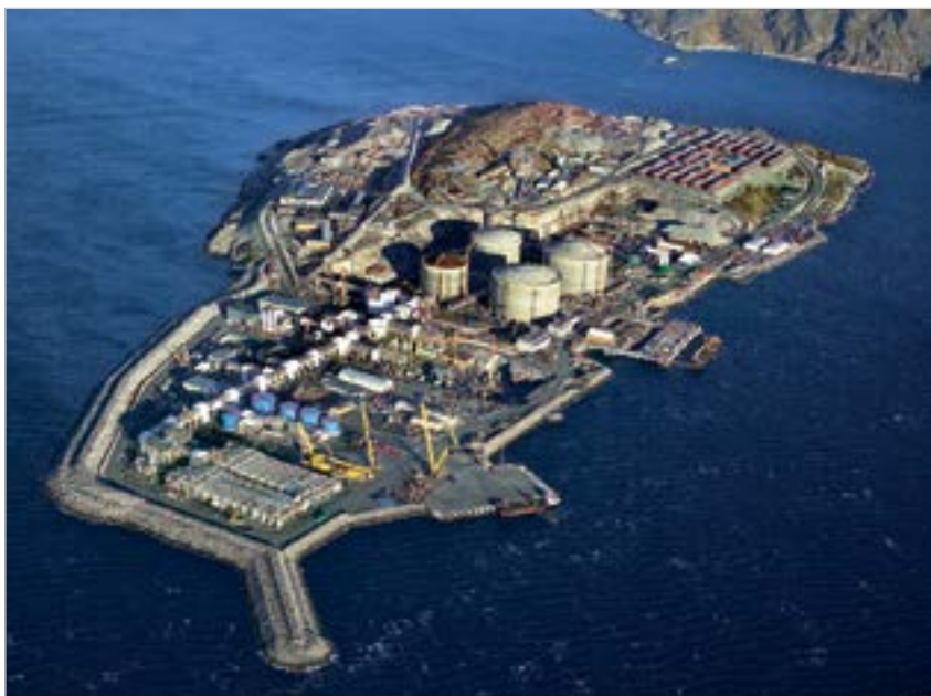
Рис. 7. Завод по производству СПГ «Сновит» (о-в Мелкойя, Норвегия)
