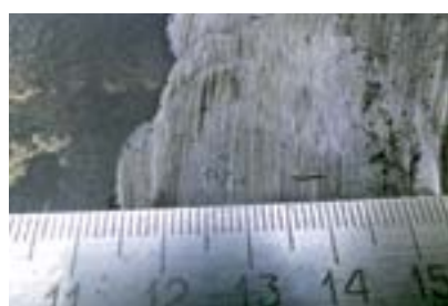
Глубина шлифовки 2 мм, длина трещины 5 мм
