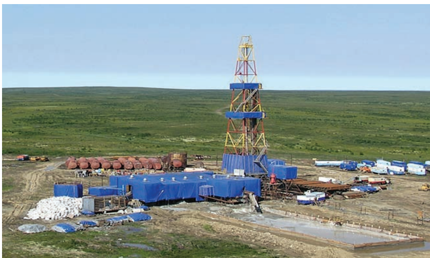
Рис. 3. Внешний вид буровой установки
