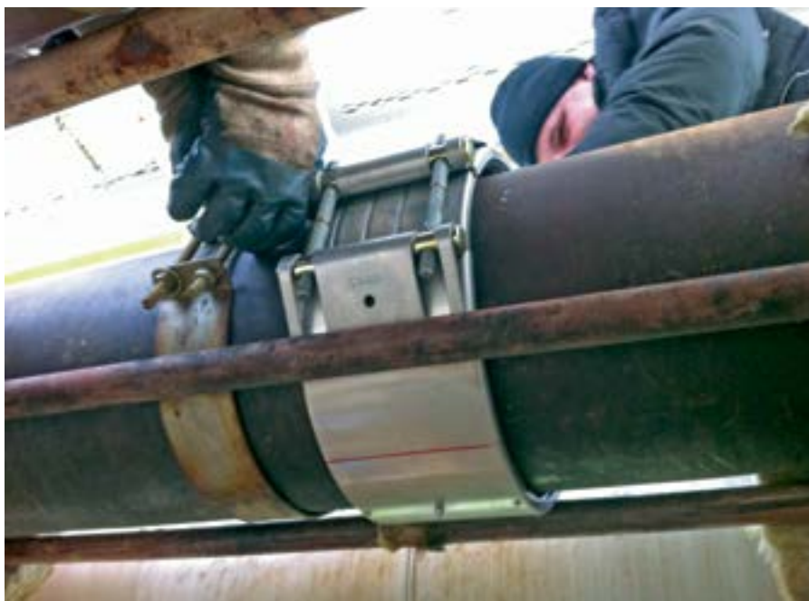
Рис. 4. «Киришинефтеоргсинтез». Ремонт игольчатого свища на трубопроводе муфтой STRAUB-OPEN-FLEX
