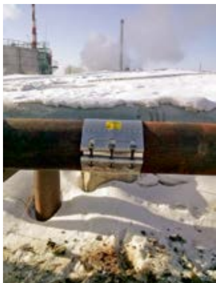
Рис. 3. Хабаровский НПЗ. Ремонт свища на сварном шве ремонтной муфтой STRAUB-CLAMP
