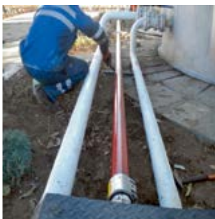
Рис. 5. Petrobrazî, Petrom (Румыния). Монтаж участка трубопровода двумя соединительными муфтами STRAUB-FLEX
