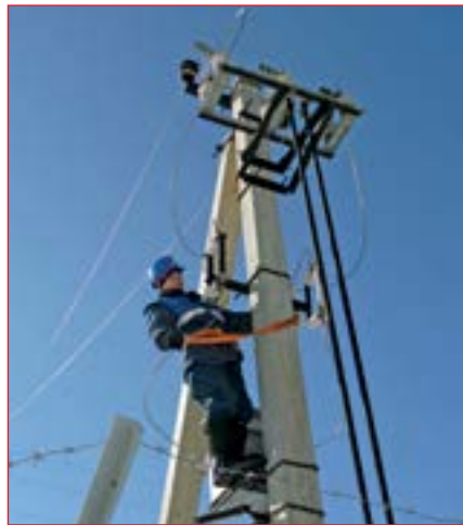
Рис. 2. Техническое обслуживание воздушной линии
