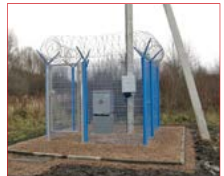
Рис. 3. Установка катодной защиты после капитального ремонта
