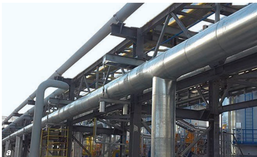
Рис. 3. Периодические подъемы участков коллектора газа регенерации в районе хомутовой опоры
