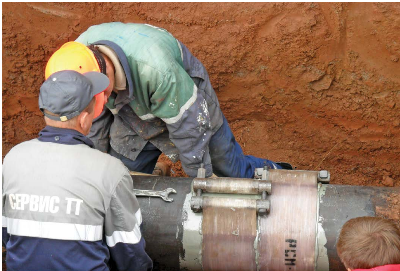
Рис. 3. Установка муфт на дефектах, выявленных ВТД
