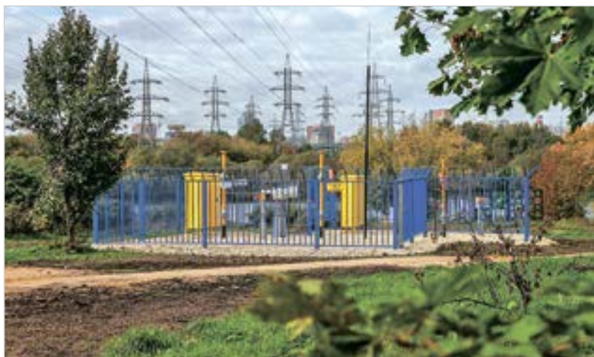
Рис. 2. Крановый узел
