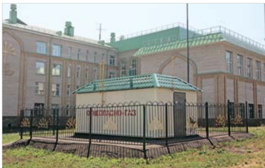
Рис. 8. ГРП ОАО «Газпром газораспределение Уфа»
