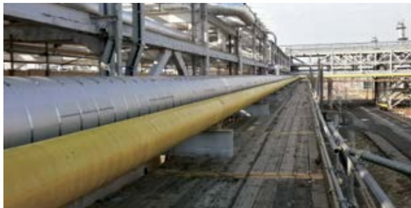
Рис. 3. Восстановление несущей способности трубопровода композитными материалами
