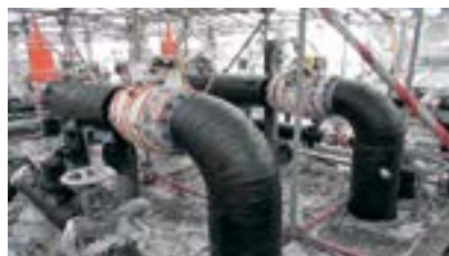
Рис 2. Монтаж теплоизоляции и нанесение мастики
