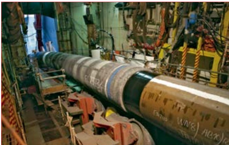
Рис. 2. Процесс обетонирования и подготовки к монтажу подводного трубопровода
