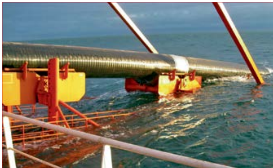
Рис. 3. Момент строительства подводного перехода через Байдарацкую губу
