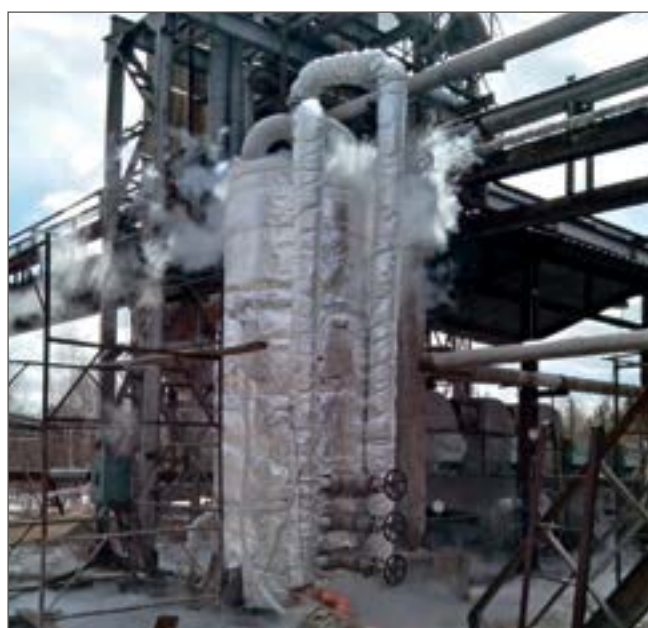
Рис. 2. Стенд во время испытаний
