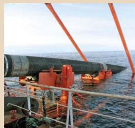
Рис. 5. Укладка трубопровода S-образным способом
