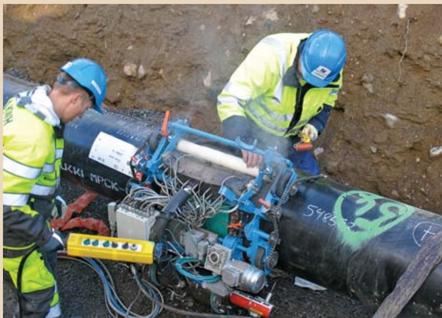
Рис. 3. Нанесение в трассовых условиях полимерных материалов методом боковой экструзии
