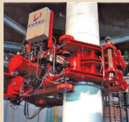
Рис. 2. Внешний вид установки изоляции стыков методом инжестирования
