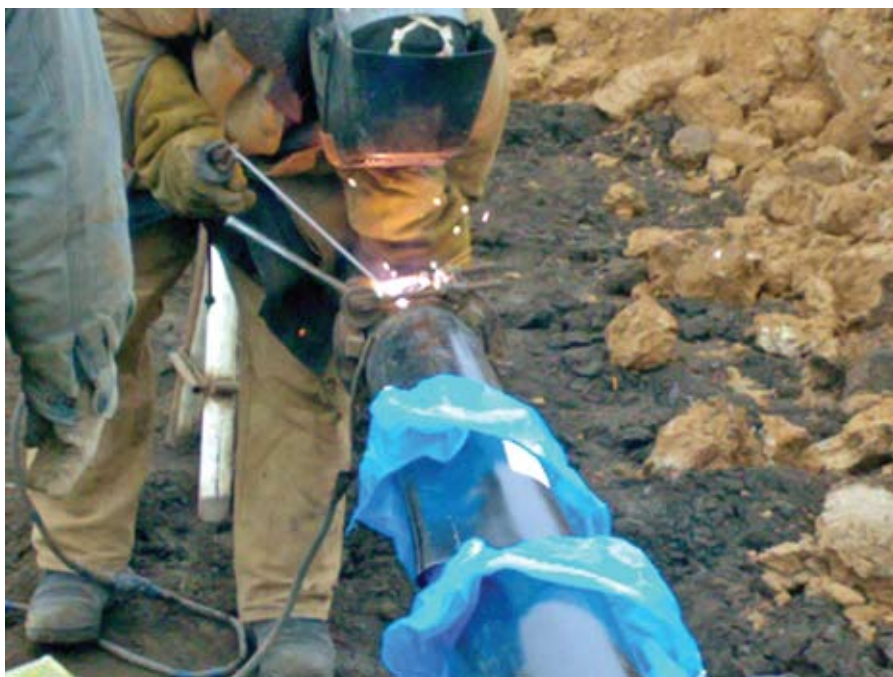
Рис. 1. Сварка стыка с последующей изоляцией комплектом ЛИТКОР
