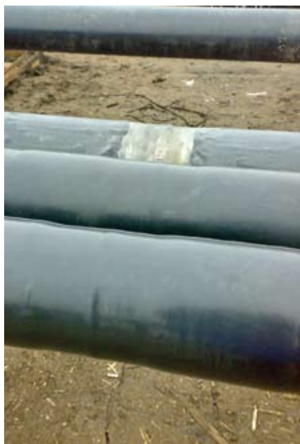
Рис. 2. Стыки, изолированные комплектом ЛИНКОР КМ
