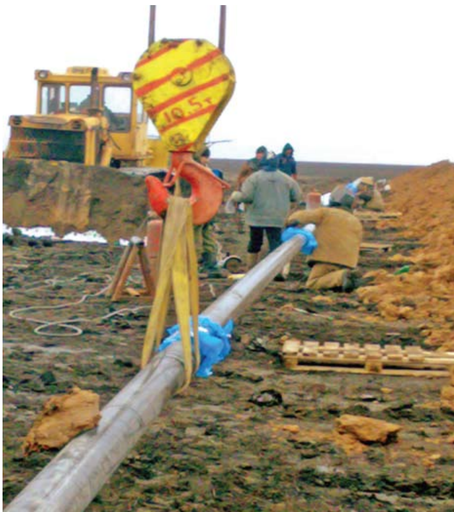
Рис. 2 Монтаж трубопровода с изоляцией стыков комплектами ЛИНКОР КМ
