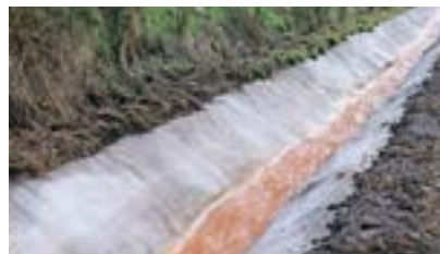
Укрепление канавы фальсификатом и бетонным полотном Concrete Canvas
