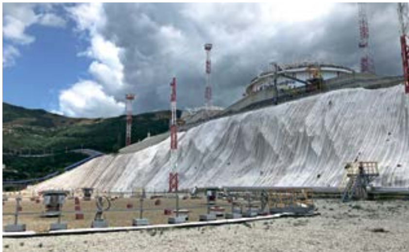
Укрепление склона бетонным полотном Concrete Canvas (ПАО «Транснефть»)
