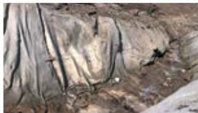
Укрепление канавы фальсификатом и бетонным полотном Concrete Canvas
