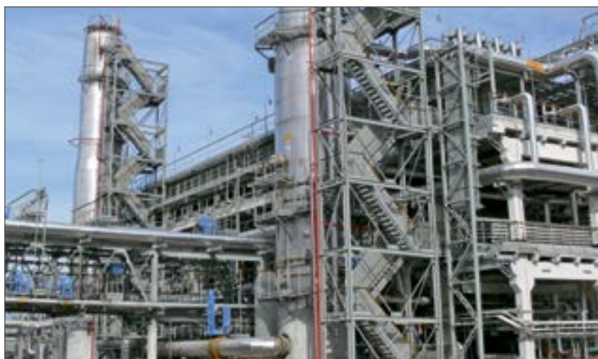
Рис. 1. Установка по производству СУГ
