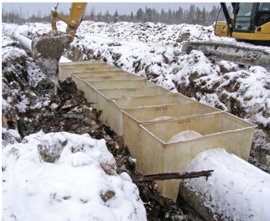
Рис. 3. Монтаж полимерно-контейнерных устройств (ПКУ)
