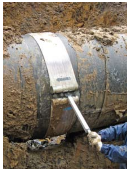
Рис. 2. Монтаж двухразъемной стеклопластиковой муфты
