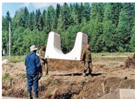
Рис. 4. Установка ПКУ -1420 на трубопровод
