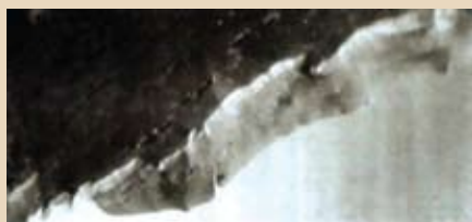
Рис. 2. Механический лом стресс-коррозионной трещины без видимых следов коррозии на внешней КЗП после 18 лет эксплуатации трубопровода [1]
