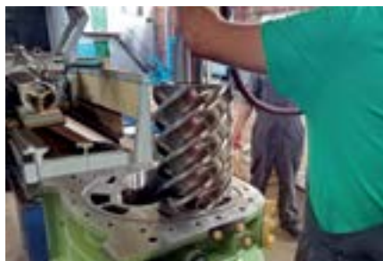
Фото 5. Ремонт компрессоров для КС № 4 «Западный Тэбук»
