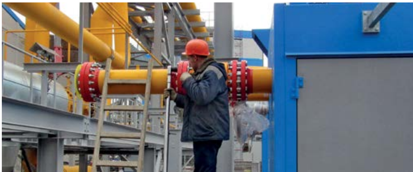
Фото 2. Строительно-монтажный этап. Трубопроводная обвязка компрессорной установки
