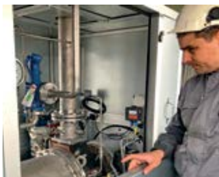
Фото 3. Собственные испытания оборудования завершают этап пусконаладочных работ
