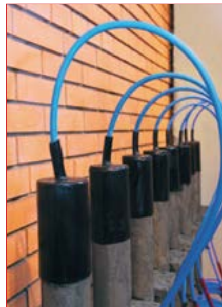
Рис. 4. Ферросилидовые анодные заземлители
