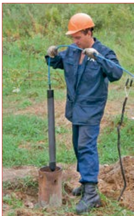
Рис. 6. Монтаж магнетитовых анодных заземлителей
