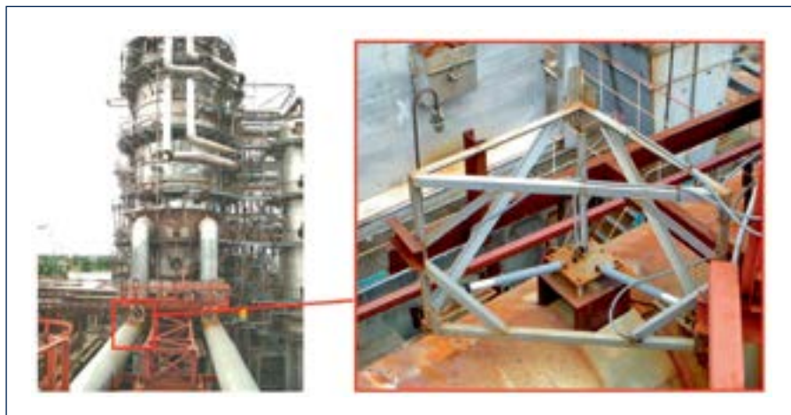
Рис. 3. Вакуумная колонна уст. ЭЛОУ+АВТ-6. Место установки и пространственная ориентация датчиков абсолютных перемещений
