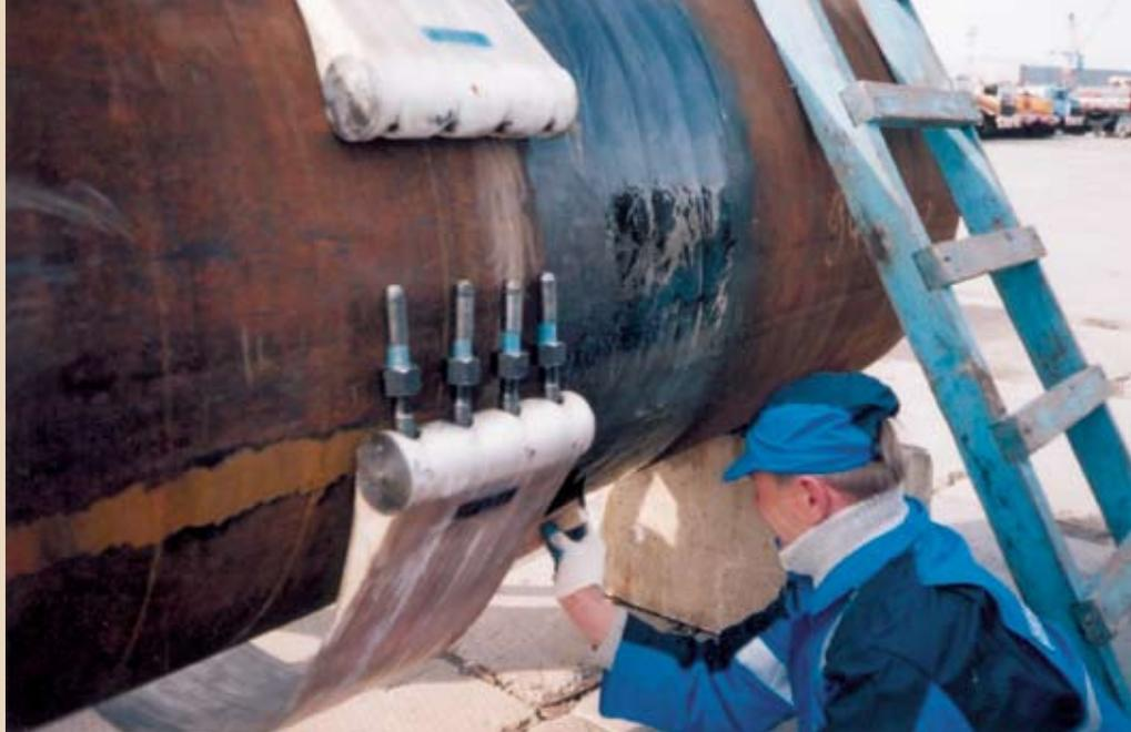
**Рисунок 2. Стеклопластиковая муфта РСМ–1220 в момент установки на трубу диаметром 1220 мм**
