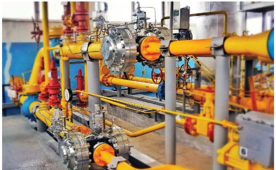
стандартного, осевого исполнения регуляторов давления серии CRONOS, также присутствует исполнение потока под 90°, т.е. угловое. Это усиливает положительный эффект по сокращению линейных размеров линий редуцирования и, соответственно, общего габаритного размера установки в целом.
