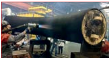
Рис. 2. Нанесение полиэтиленового слоя покрытия газопламенными пистолетами
