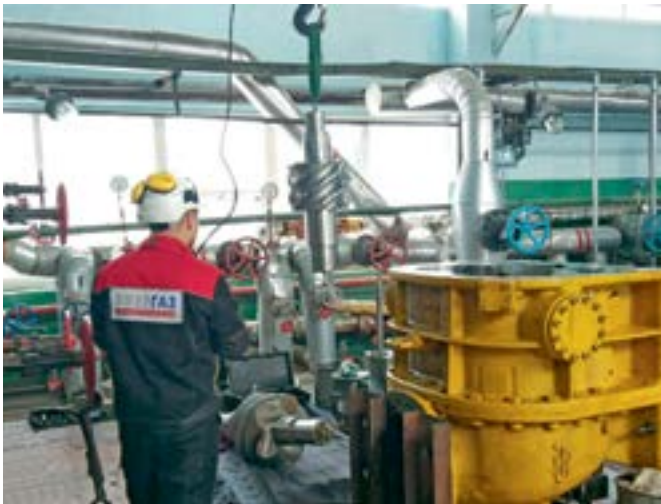
Фото 7. Капремонт газового компрессора на Южно-Сахалинской ТЭЦ-1
