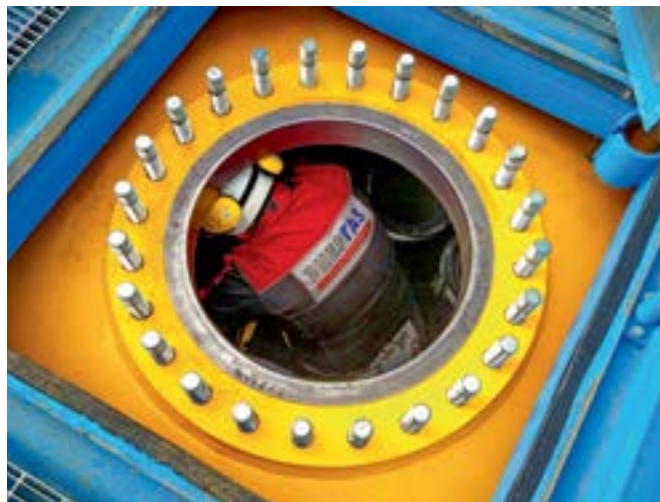
Фото 6. Замена фильтрующих элементов сепаратора 1-й ступени очистки на дожимной компрессорной станции топливного газа
