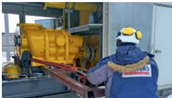
Фото 4. Демонтаж оборудования газоподготовки в ходе ремонтных работ на ПГУ-225 Сызранской теплоэлектростанции
