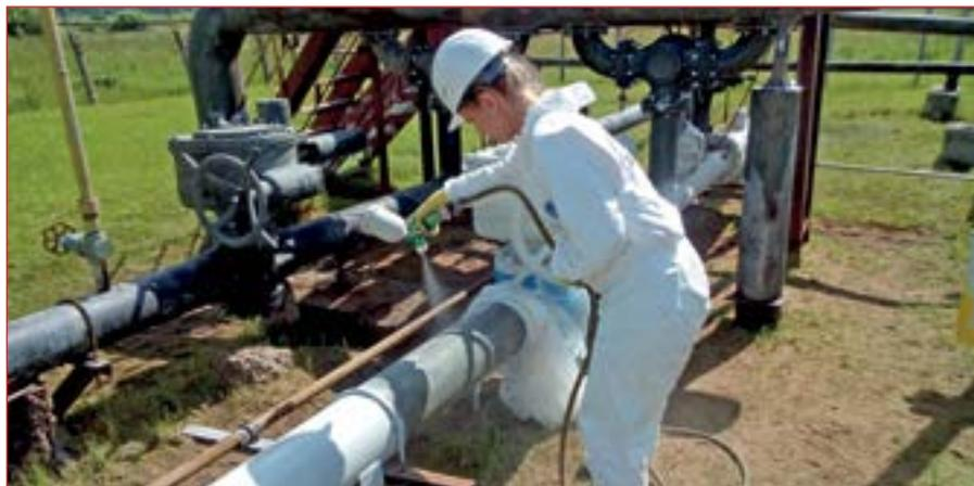
функции грунтовочного покрытия и декоративные – финишного. Так, один слой грунт-эмали Prodecor 1202 заменяет традиционную классическую схему, состоящую из трех слоев системы ГФ-021 + ПФ-115. Срок службы покрытия на основе грунт-эмали в условиях умеренного и холодного климата составляет не менее 7 лет.
