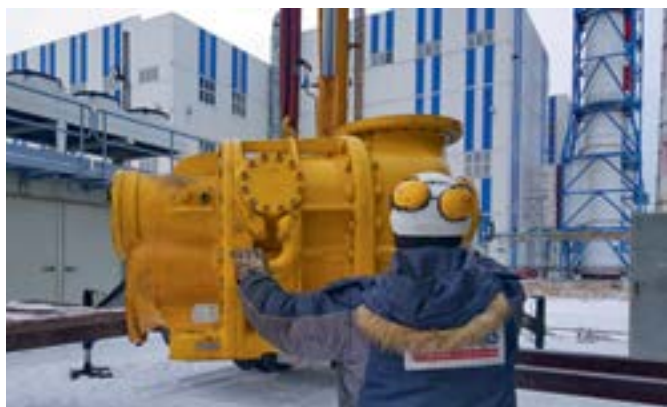
Фото 5. Демонтаж оборудования газоподготовки в ходе ремонтных работ на ПГУ-225 Сызранской теплоэлектростанции
